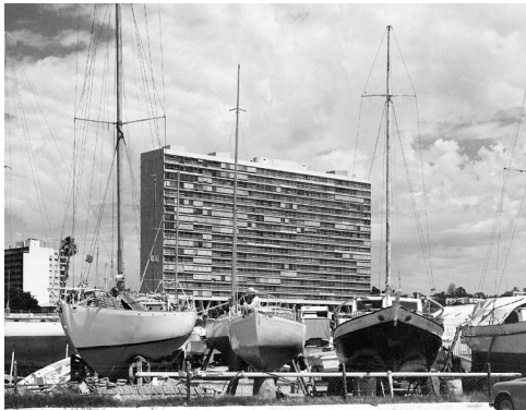
Figura 1. Edificio Panamericano. Montevideo, 1958. Versión construida. Arq. Raúl Sichero. Fotografía: Arq. César Loustau. Archivo de la familia Sichero.
