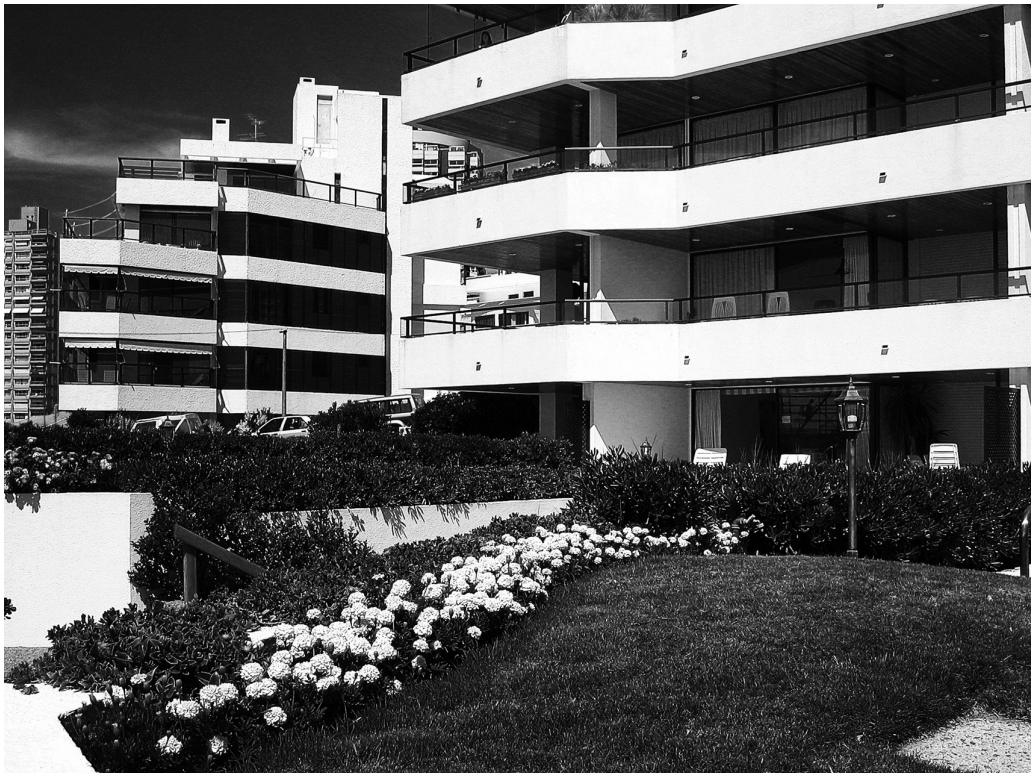
Figura 11. Edificio Amarras del Sol del Arq. Raúl Sichero y Edificio Cigale del Arq. Walter Pintos Risso. Punta del Este Fotografía: Dr. Arq. Pablo Frontini.
