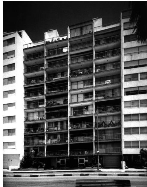
Figura 7. Edificio Finisterre. Montevideo, 1963. Arqs Rodolfo López Rey y Guillermo Gómez Platero. Fotografía: Arq. César Loustau. Archivo personal del Arq. Rodolfo López Rey.
