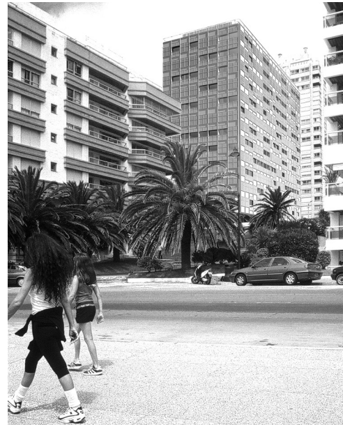
Figura 4. Edificio Bahía Palace. Punta del Este, 1955. Arqs. Antonio Bonet y Raúl Sichero. Fotografía y construcción gráfica: Raúl Sichero + Pablo Frontini.
