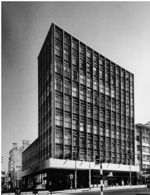
Figura 8. Banco de Crédito. Montevideo, 1958. Arqs. Juan Antonio Rius y Luis Vaia. Fotografía: Arq. César Loustau.
