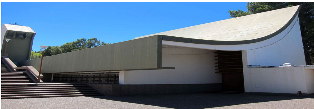
Figura 8. Vista del atrio de la iglesia, 2010.
