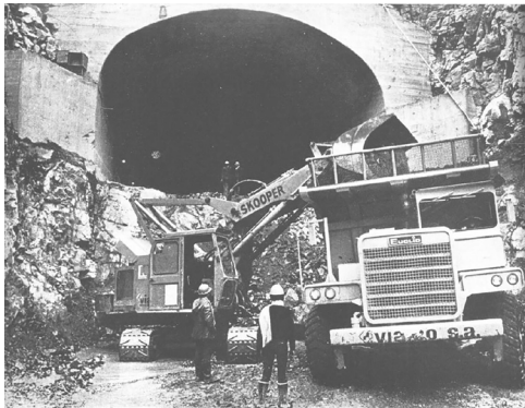
Figura 4 Construcción de los túneles. Fuente: Nuestra Arquitectura (481), enero- febrero, 1973.
