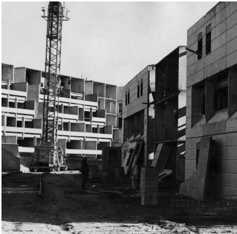
Figura 12 Construcción de viviendas con sistema Outinord por Aluar en Puerto Madryn (Chubut), 1975. Fuente: Archivo Estudio M|SG|S|S.
