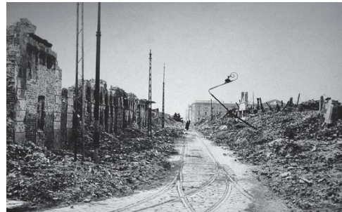
Figura 6. Vista de una calle de la ciudad de Varsovia, completamente destruida.
