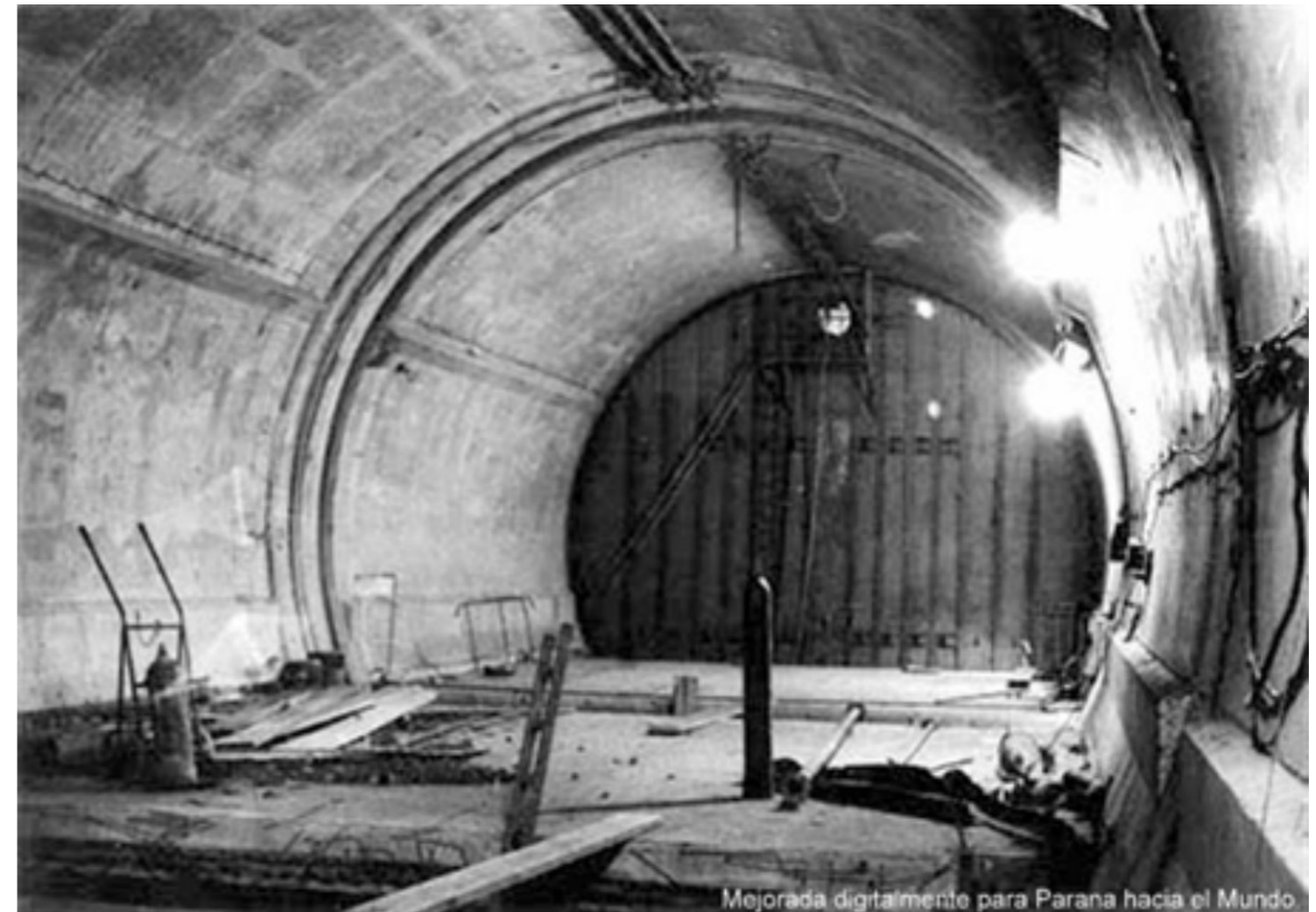
Figura 5: Trabajos en el interior de los tubos.
