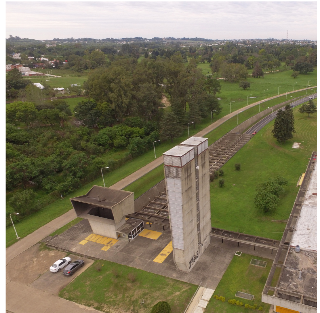
Figura 10: Torres de ventilación en el lado Paraná (extracción de aire viciado e inyección de aire limpio).
