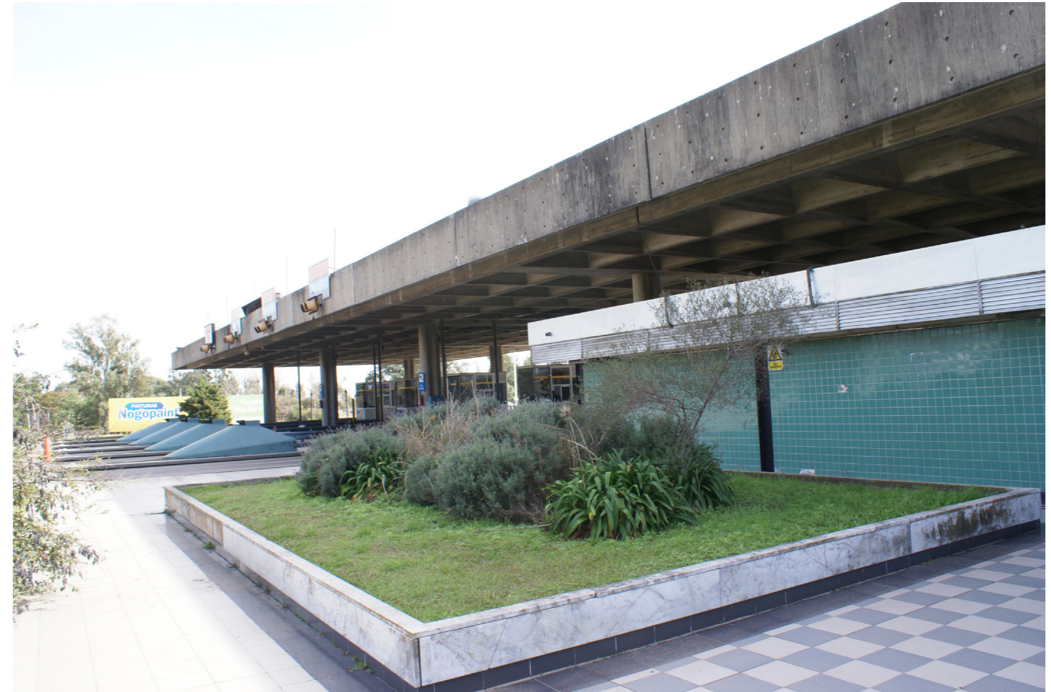
Figura 7: Cubierta de las zonas de peaje y oficinas en el lado Santa Fe.
