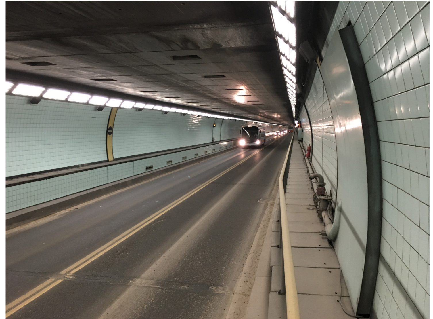
Figura 6: Interior del túnel subfluvial.
