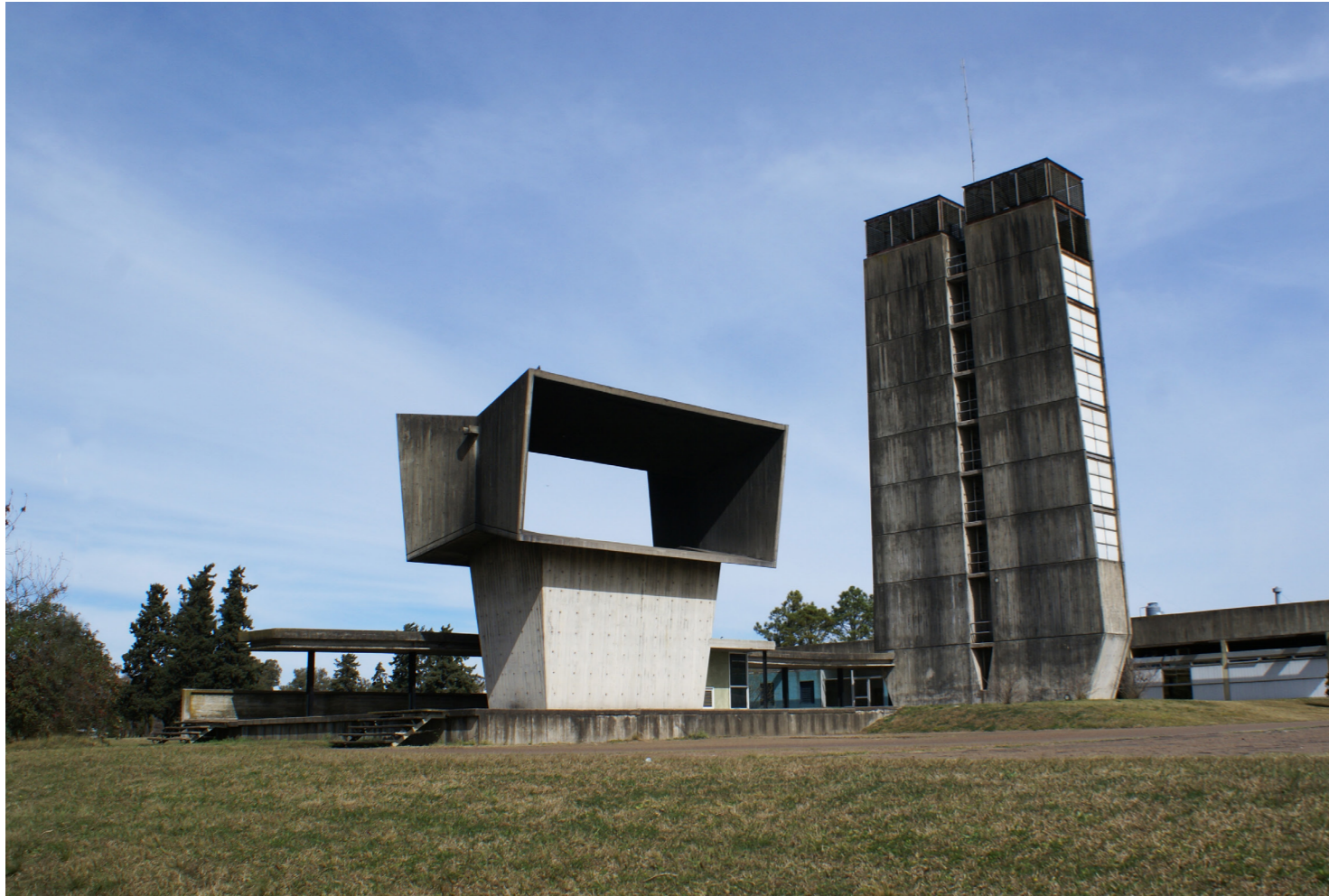
Figura 11: Torres de ventilación en el lado Paraná.
