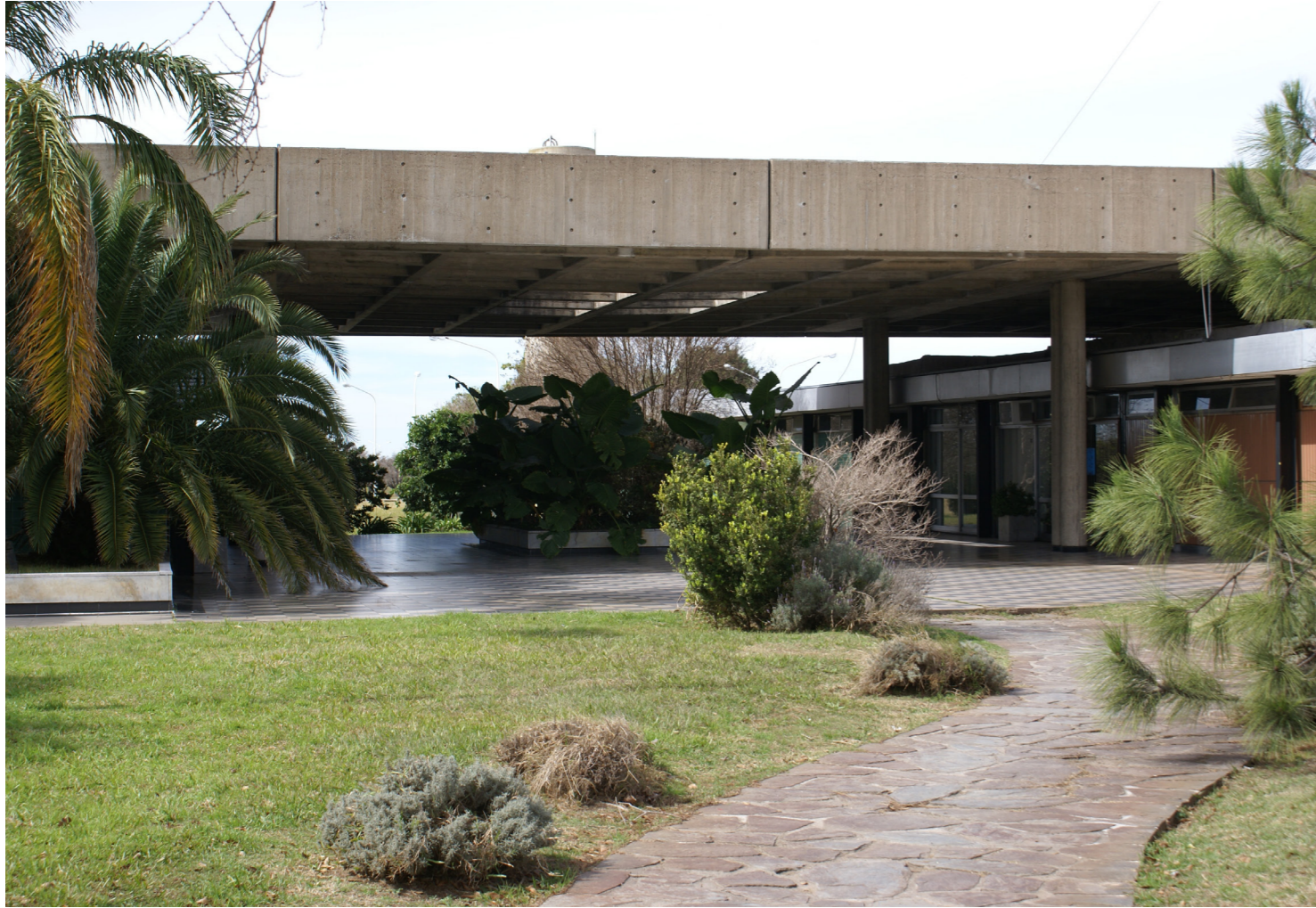
Figura 8: Sector de oficinas administrativas en el lado Santa Fe..
