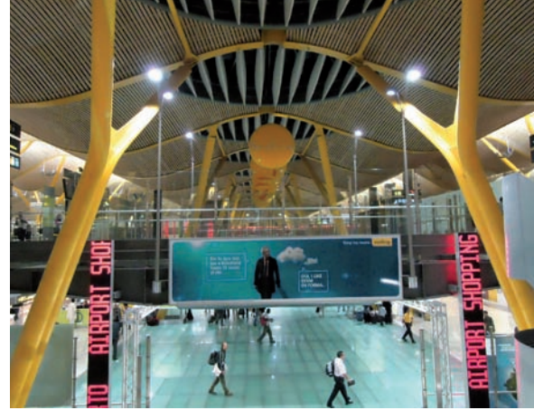
Interior T4 Aeropuerto de Barajas, España
