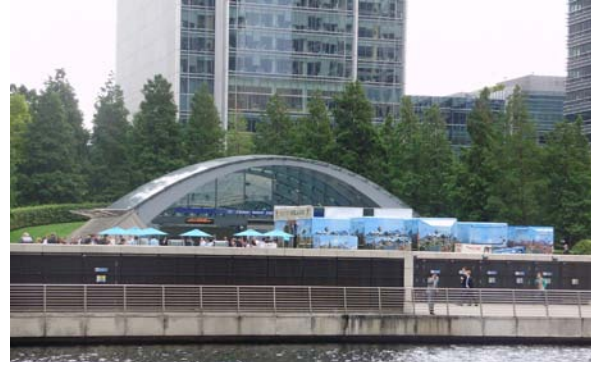
Terminal de metro Canary Wharf Fuente: Fotografía tomada por los autores www.greenroofs.com
