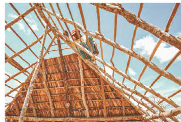
Maestro del yotojoro tejiendo una cubierta.
