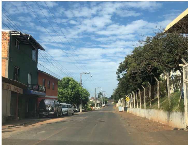
Figura 5: Vista da Rua Eduardo Pedroso da Silva, onde percebe-se a ausência de calçadas, poucos recuos e perfil estreito da mesma.
