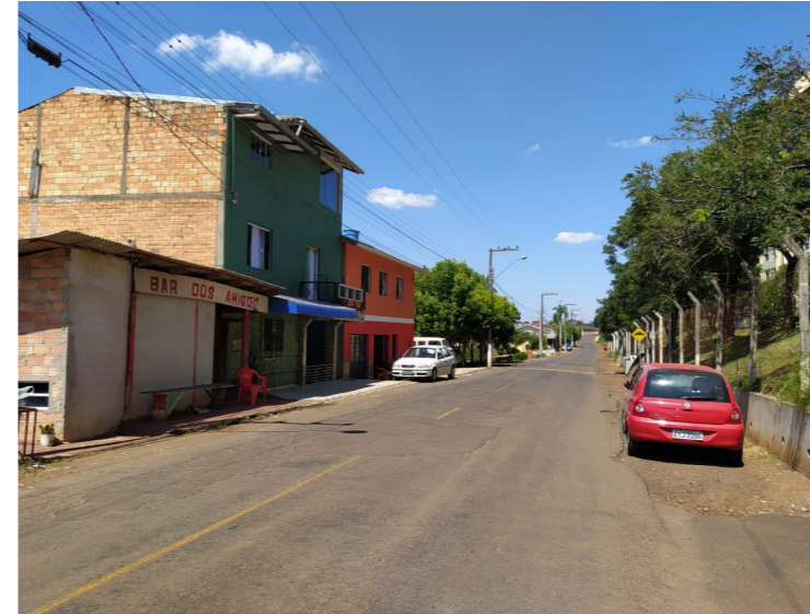
Figura 7: Rua Eduardo Pedroso da Silva, com destaque para a via, cuja configuração não satisfaz as necessidades do local.
