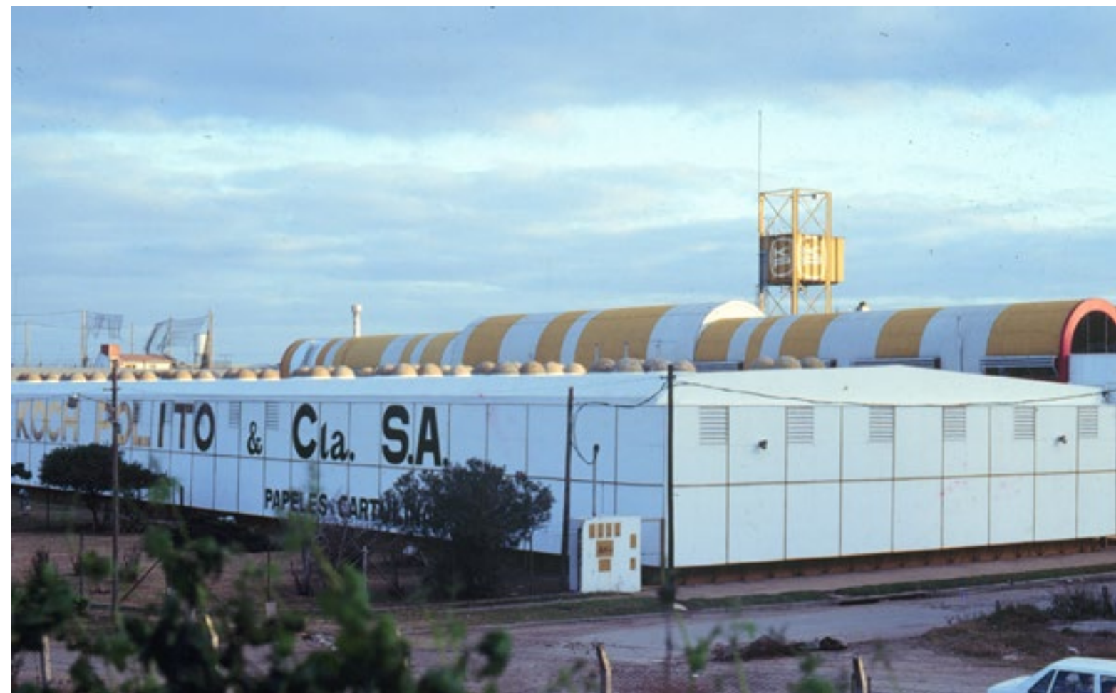
Figura 6: BDELTV: Bóvedas de chapa de poliéster y cúpulas acrílicas en la cubierta de Koch Polito.
