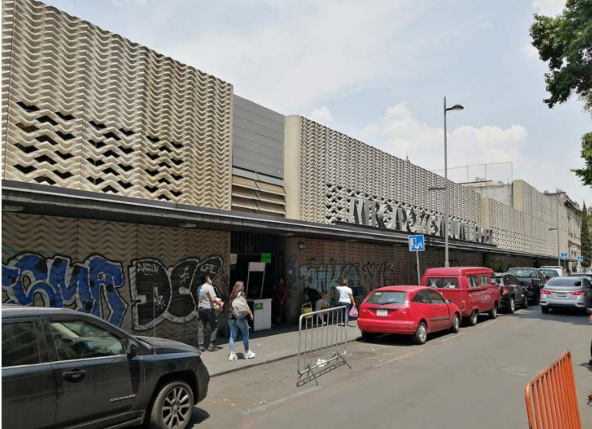
Figura 5. Fachada del Mercado San Juan E. Pugibet; Ciudad de México, México.
