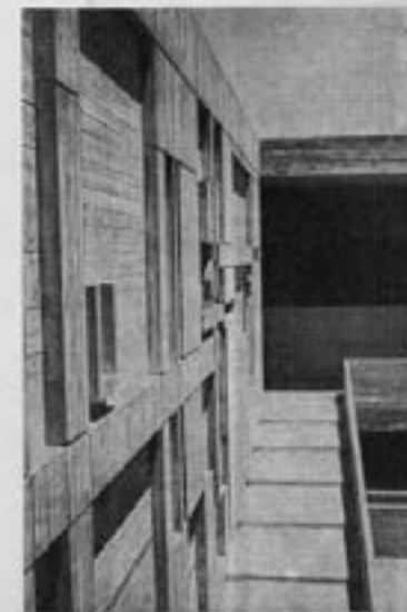
La gradinata, sustentada por la pantalla que sostiene el mural, conduce a las vistas superiores.
