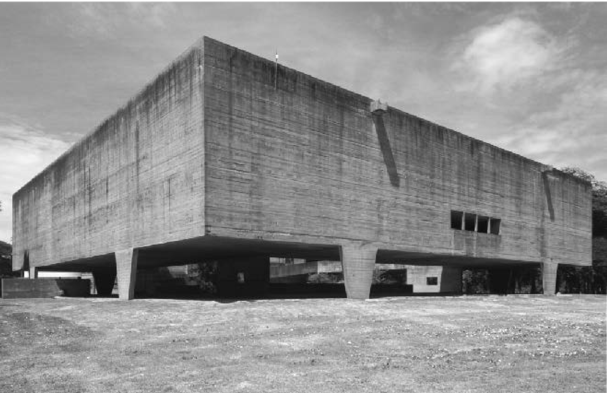
Figura 13. Vista actual del urnario municipal, tomada desde en noreste.
