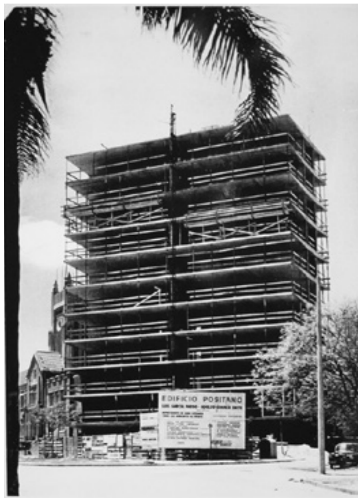
Figura 2. Fotografía del Positano en obras.
