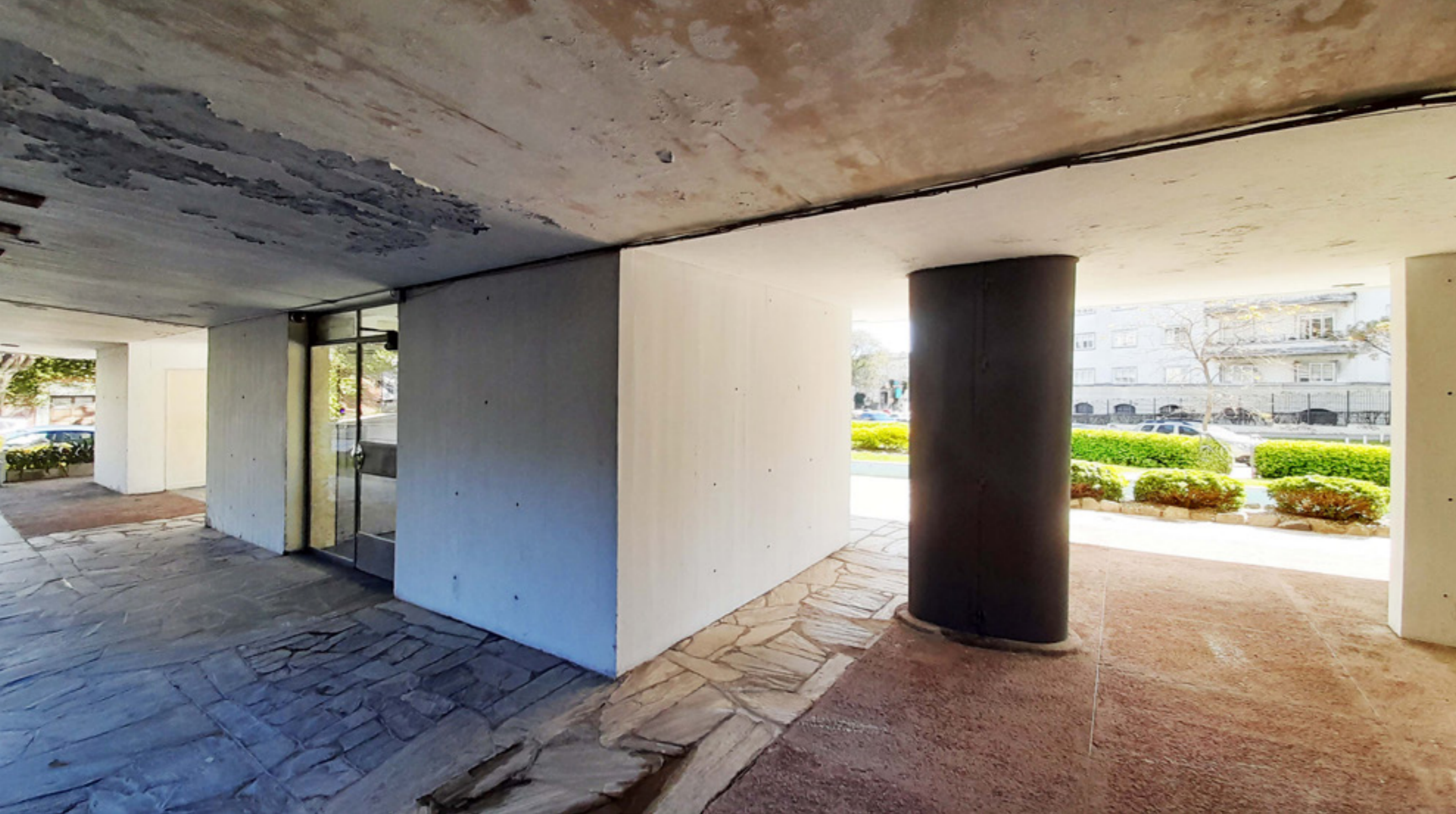
Figura 8. Vista de la planta baja.
