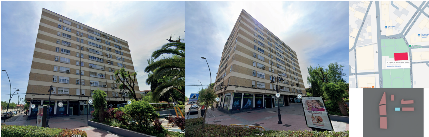
Figura 1b. Vista del edificio residencial situado en Plaza España, 6, Getafe (Madrid), acompañado por su ubicación en el entorno urbano y esquema volumétrico del emplazamiento. Fuente: Google Maps (2025).
