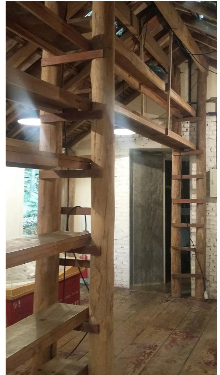
Figura 4. Lina Bo Bardi. Casa de Vidrio, São Paulo (Brasil), 1949/51. Vista interior del estudio.
