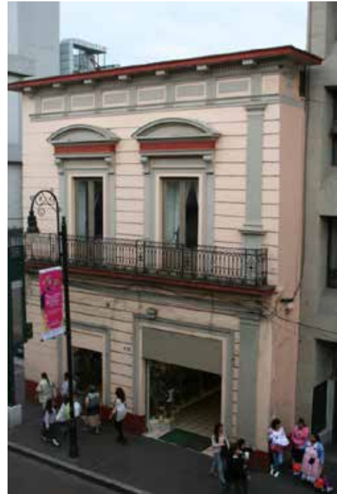
Figura 01. Casa porfiriana en Toluca, calle Hidalgo poniente n. 201 (Estado de México).
