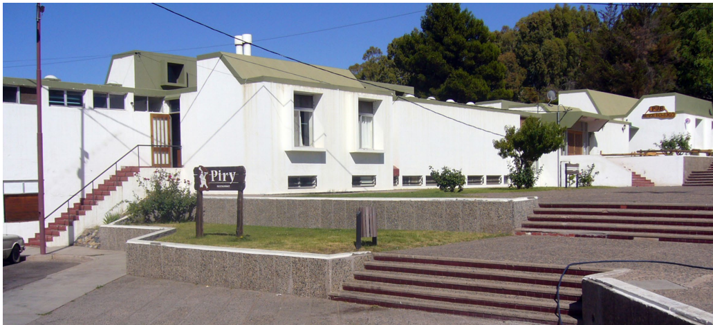
Figura 7. Vista del centro cívico, circulación peatonal, 2007.
