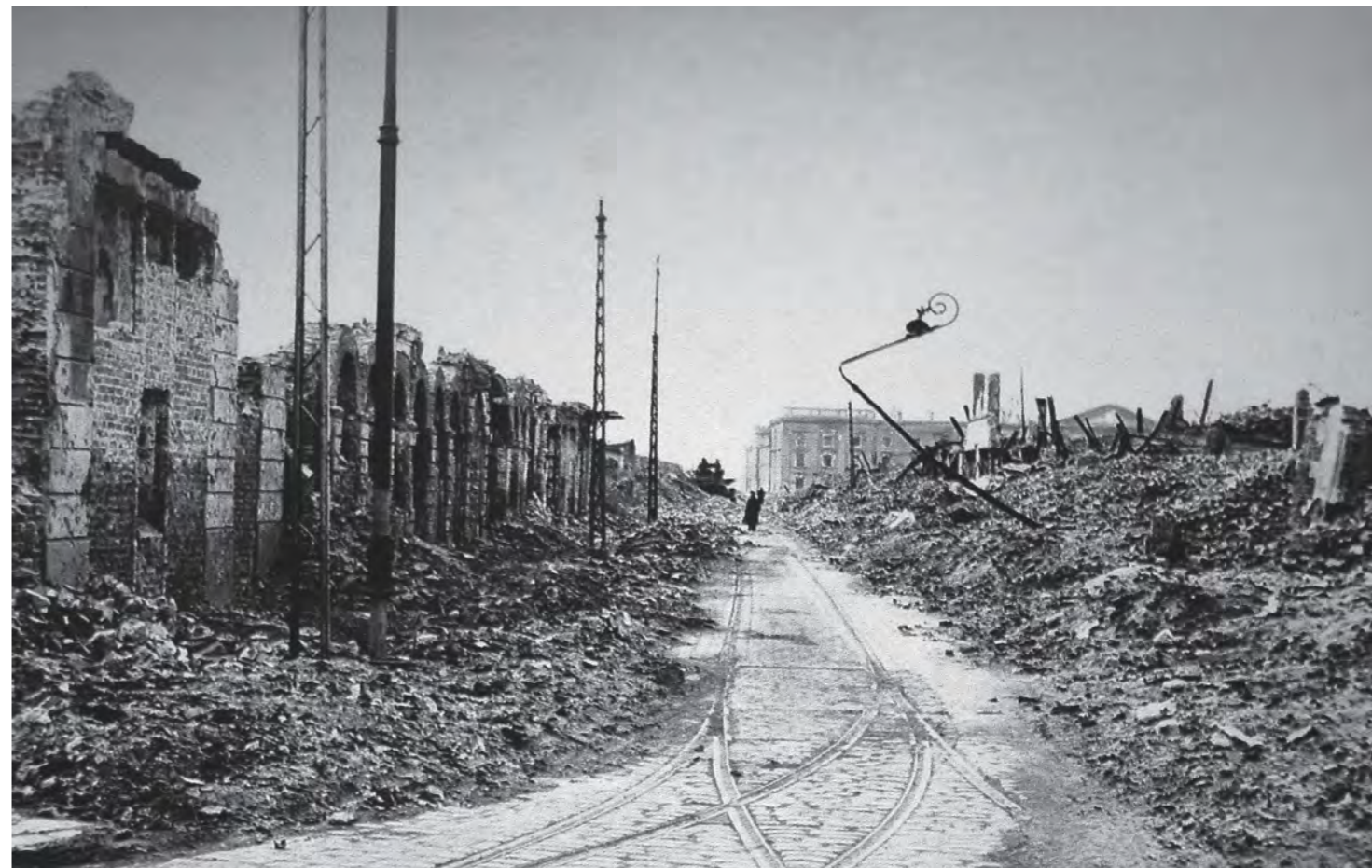
Figura 6. Vista de una calle de la ciudad de Varsovia, completamente destruida.
