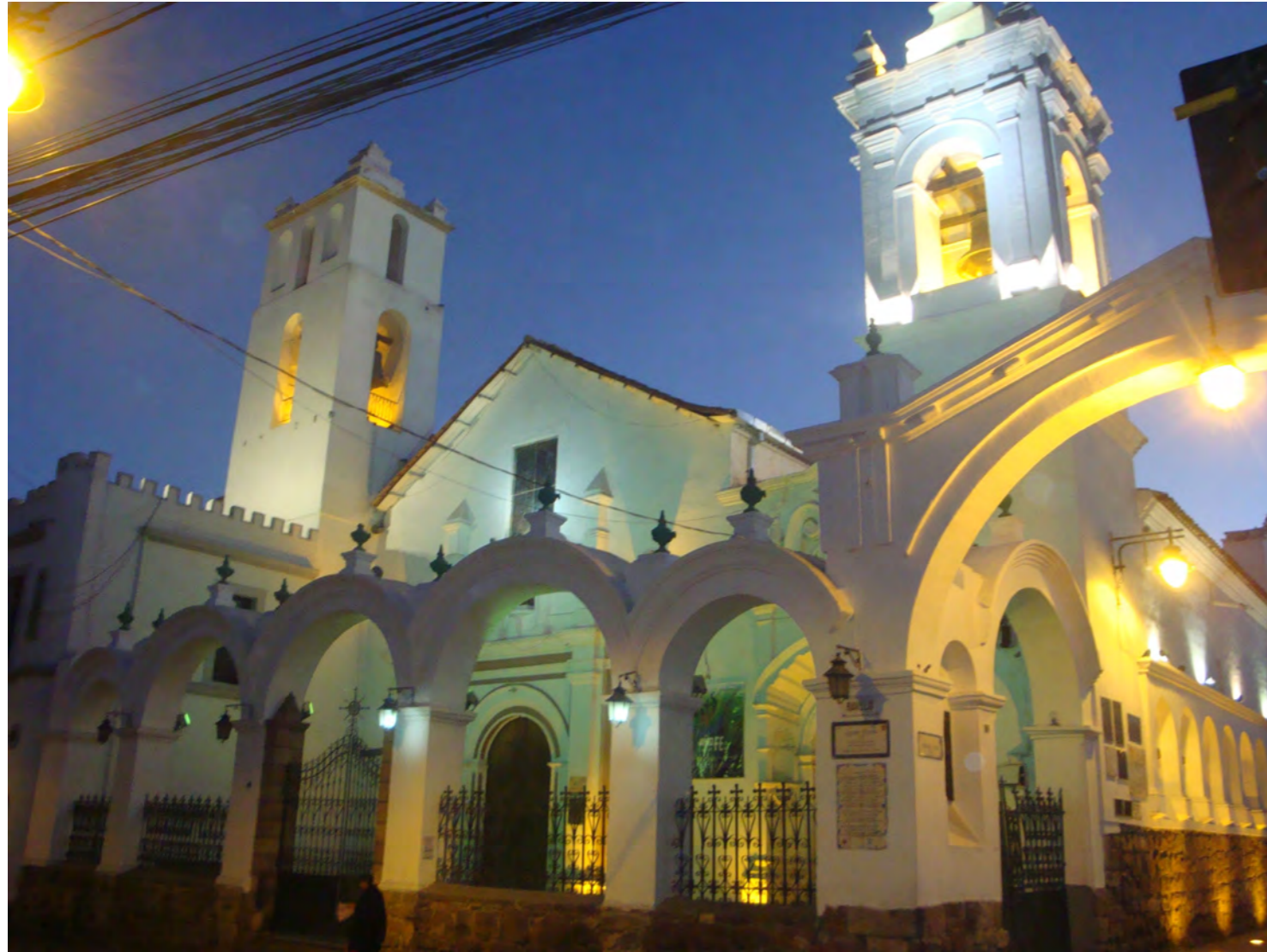
Figura 2. Fachada del templo por la calle capitán Ravelo. Fotografía propia (2019)
