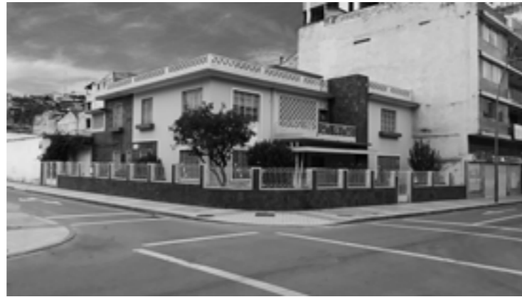
Figura 11: Perspectiva fotográfica 01 de la residencia Valdivieso.
