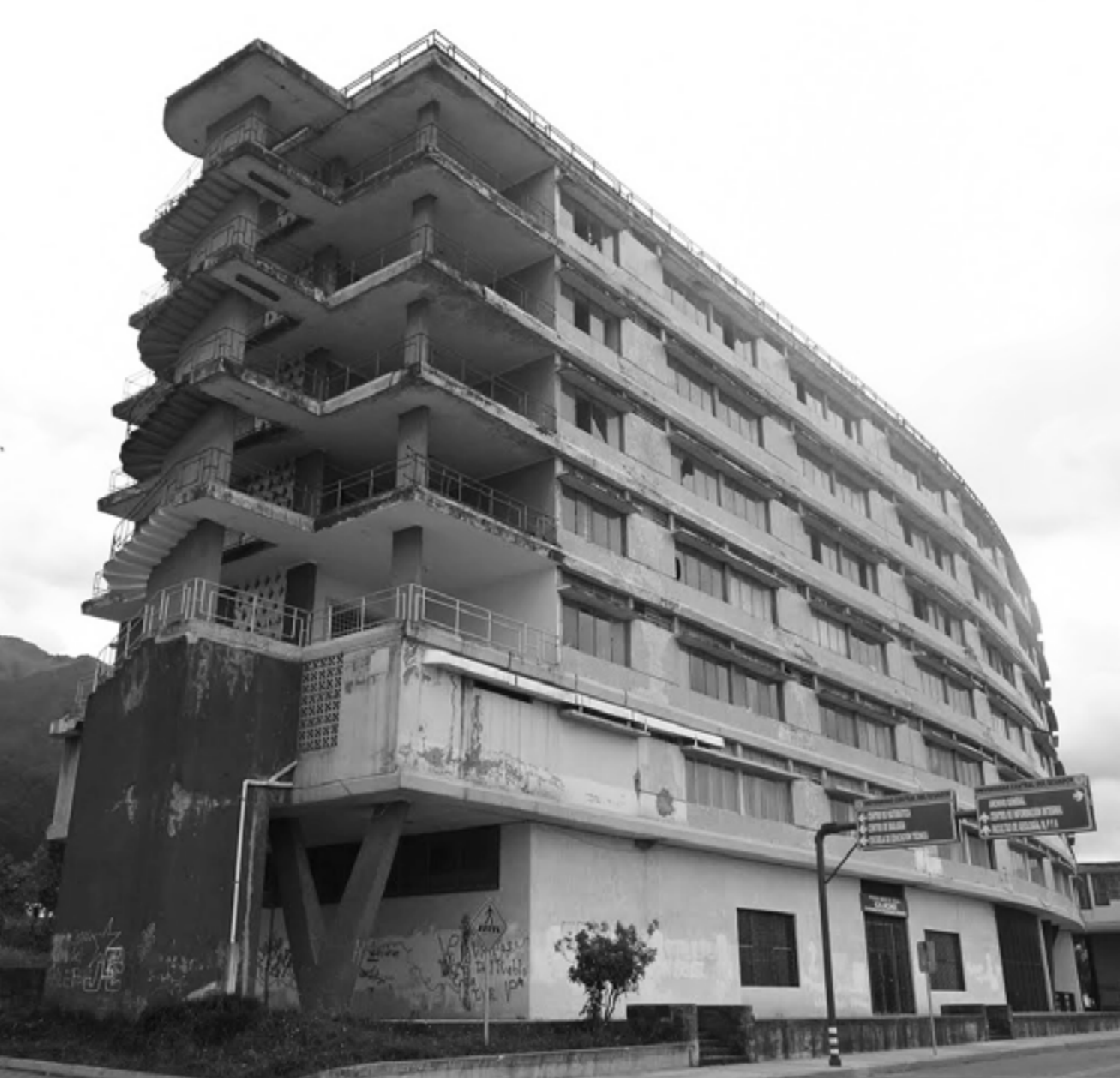
Figura 8: Residencia universitaria construida por Gilberto Gatto Sobral.
