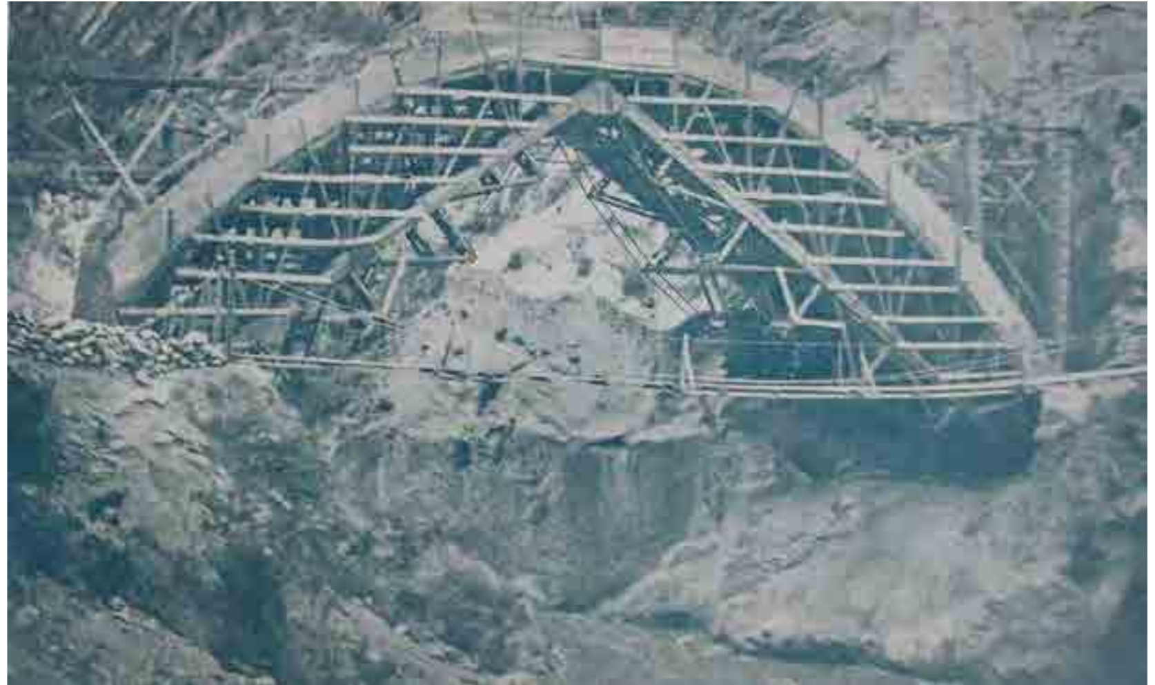
Figura 11: El puente principal del camino a Cacheuta, durante su construcción.
