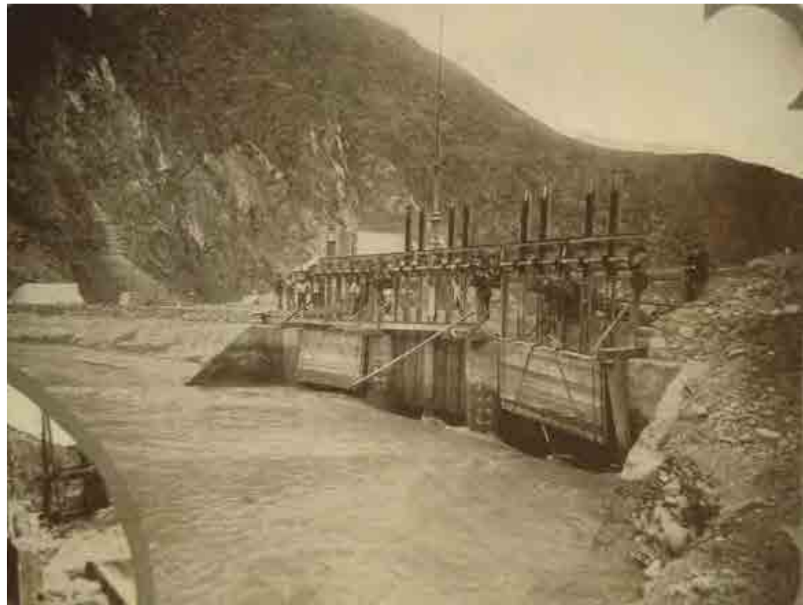
Figura 3: Vista del dique de toma terminado, usina Fader (1910).
