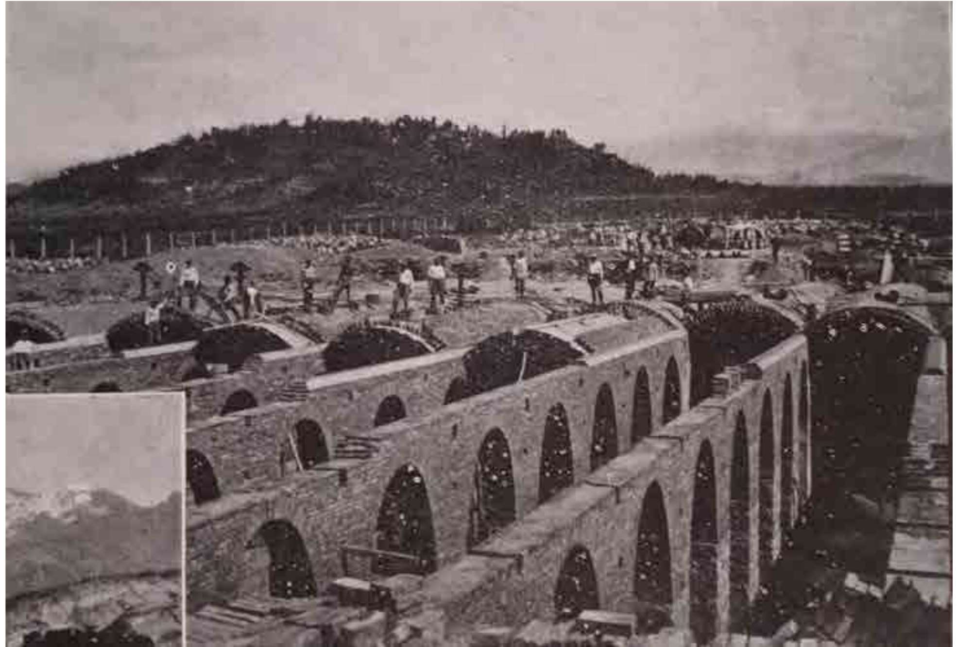
Figura 14: Vista de las obras de ampliación en la planta de Alto Godoy.
