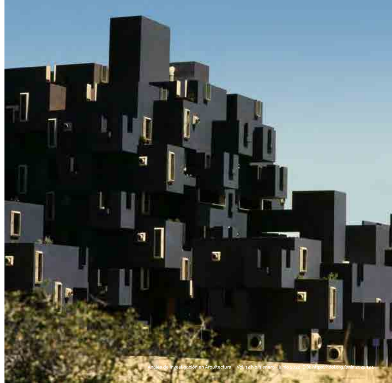
Figura 11. Edificio de Apartamentos Castillo de Kafka. Taller de Arquitectura (1968)
