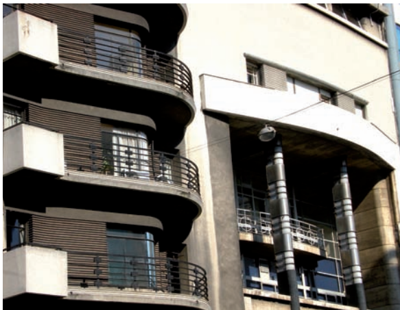
Edificio Confitería La Americana. Carlomagno, Bouza, González Fruniz, 1937
