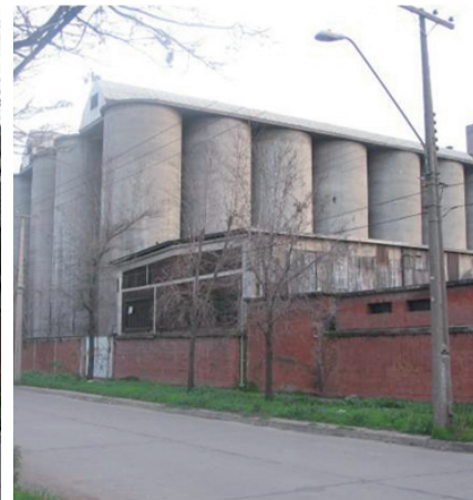
Ex Empresa de Comercio Agrícola (demolida)
