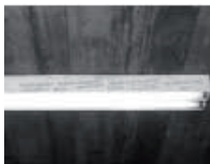
LD, salón 22, techo, cubierta tubos de luz
